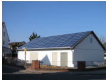
solare Ganzdachlösung bei einer Gasreglerstation
